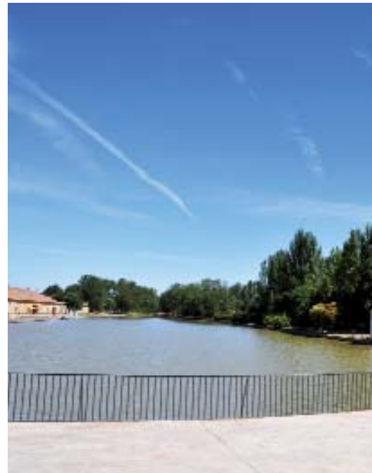
Dársena de Medina de Rioseco y antigua fábrica de harinas.
